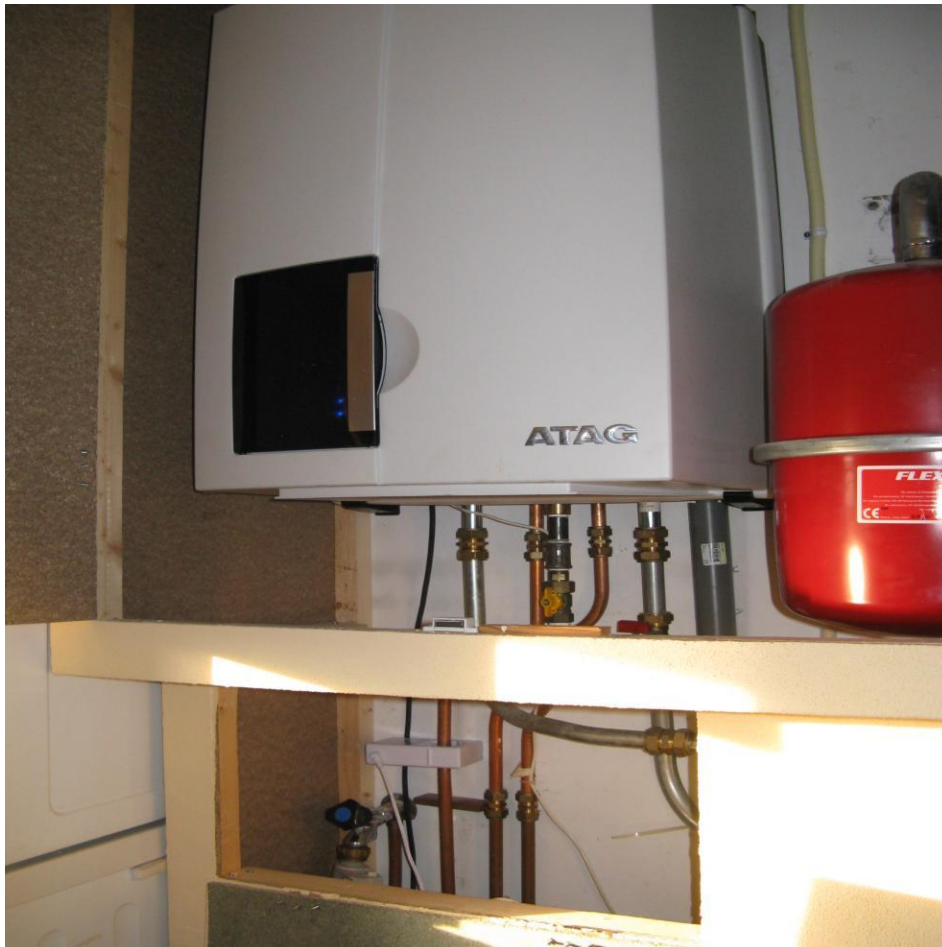
De HydroFLOW HS-38 gemonteerd onder een combiketel.
